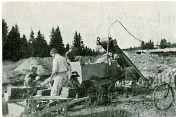
Fig. 3. Maskinfremstilling av leirblokker.
