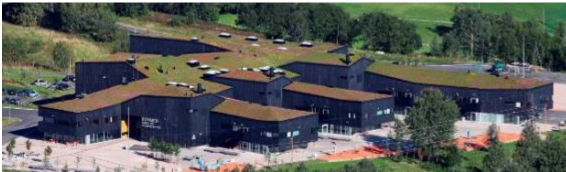
Rommen skole med sedumtak
