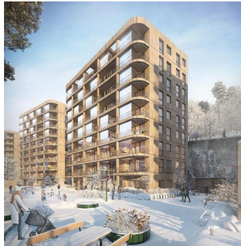
F.o.m. plan 03 i massivtre - plan 01 og 02 i betong
