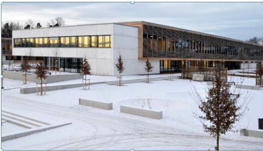
Ved Hundsvand grendesenter er det vektlagt tekniske løsninger mht energibehov og varmegjenvinning.
